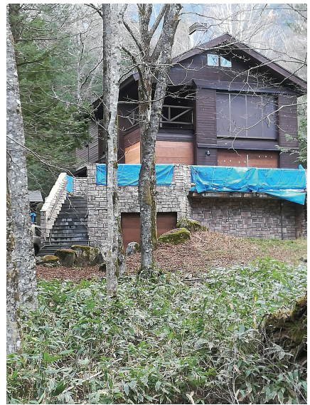
写真 2 11 月小屋閉め後
