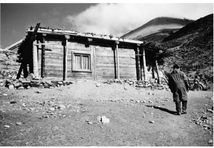
写真4 来古村の角ログの小学校職員室(図1の①)
