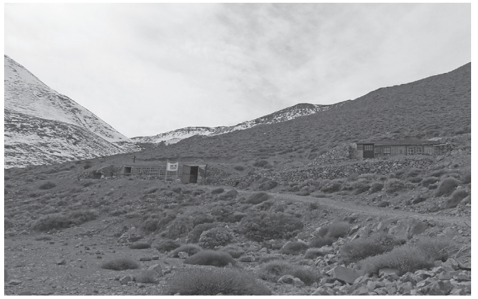
写真1 (2013年8月22日撮影): エル・アルバのベースハウス。雪崩を避けるため半地下となっている。施設は右がトイレ、左の構造物に小さな机が3つと椅子が数個ある待合室、ガイドの準備室、キッチンがある。標高2690m。雪が少ない。
