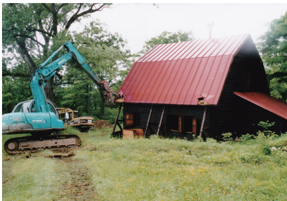
写真2 1999年7月3日、改築のため、旧ヒュッテを解体、撤去するところ
