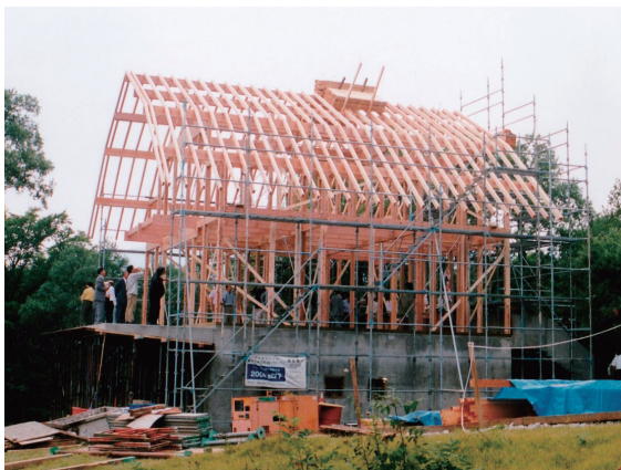
写真4 改築途中、およその骨組みができた状態
