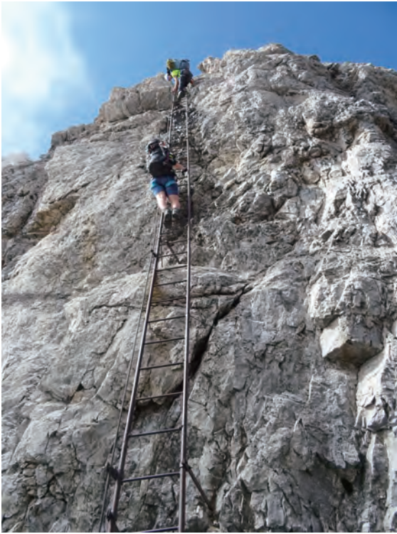
写真5 垂直に近いところにはこのような梯子が懸かっている(2018.7.24撮影)。ワイヤーが横に張ってあるので、これにカラビナを掛けておけば下まで落ちる心配はない。梯子はしっかりしていて全くぐらつかない。頂部には手摺りがある。これは20mぐらい。
