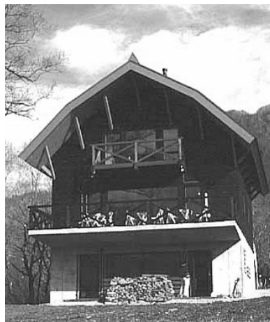
完工なった新笹ヶ峰ヒュッテ
